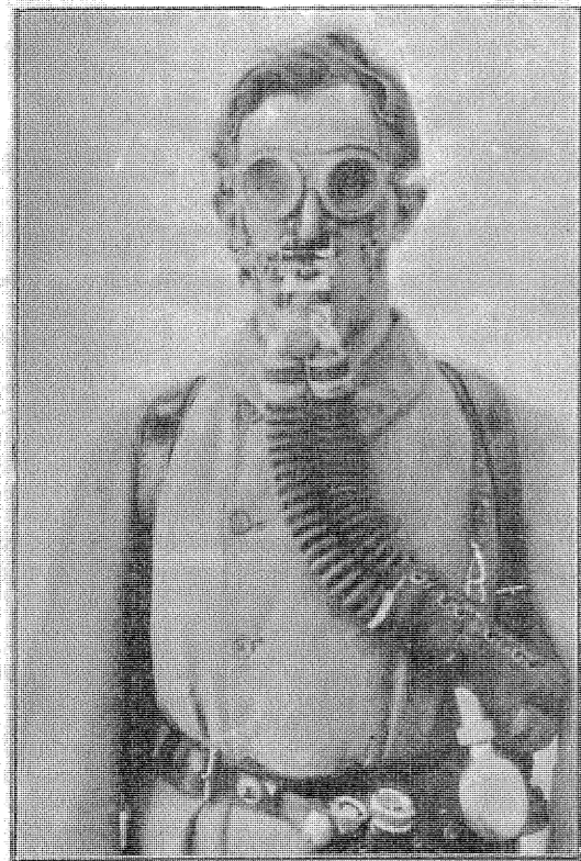
Lekki aparat przeciwigazowy, używany przez kadry ratownicze w kopalniach węgla.
