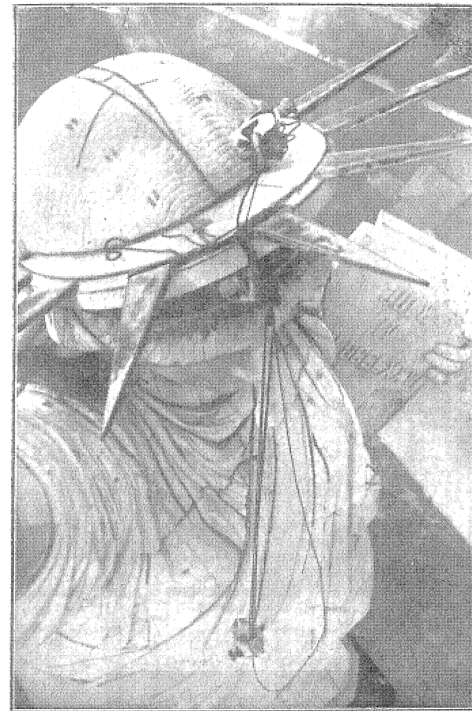
Toaleta „Pesagu Wolności”, wzniesionego u wejścia do portu w Nowym Yorku. Fot. nasza przedstawia górną część posągu, budowanego z olbrzymich bloków betonowych, o imponującej wysokości ponad sto metrów.
