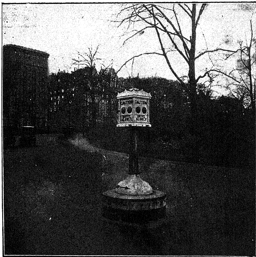
Na wszystkich wielkich placach, parkach i t. p. w Ameryce ustawione są wieżyczki, które zapomocą sygnałów świetlnych regulują ruch automobilowy.
