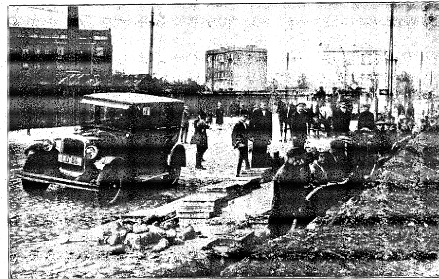
Prace nad zakładaniem nowego kabla przy ulicy Prez. Narutowicza w Łodzi.
