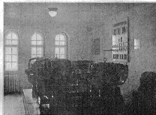
Wnętrze warszawskiej stacji telefonicznej.
