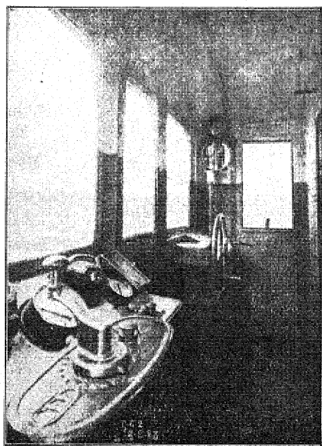
Wnętrze przedziału lokomotywy elektrycznej.
