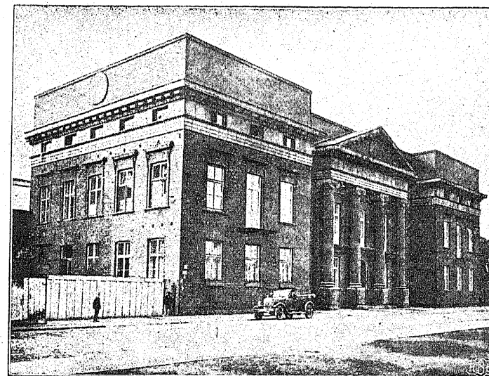
Gmach, będący siedzibą kurji biskupiej w Łodzi, przy ul. Ks. Skorupki, vis-a-vis katedry Stanisława Kostki, będący w fazie zewnętrznego uzupełnienia budowlanego.
