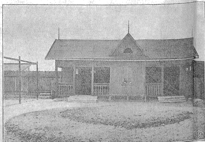
Nowowytbudowana weranda przy kortach i strzelnicy dla wodników i gości.
