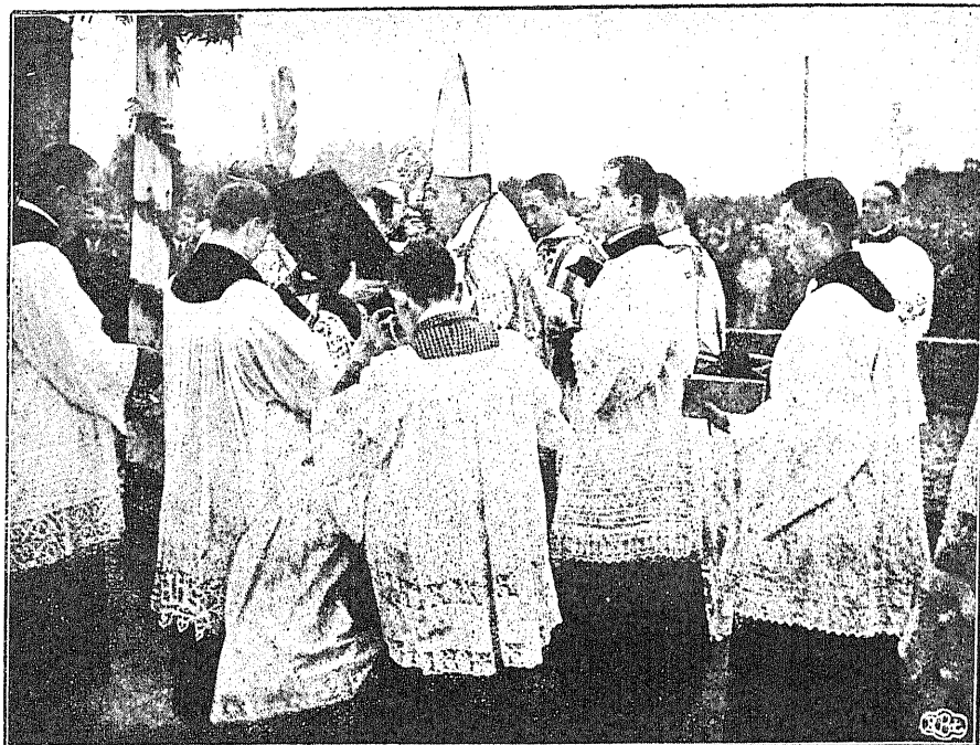
W ubiegłym tygodniu odbyło się uroczyste poświęcenie kamienia węgielnego pod budowę nowej świątyni pod wezwaniem św. Franciszka z Asyżu. Świątynia ta stanie przy Szosie Pabjanickiej. Na zdjęciu powyższym widzimy J. E. ks. biskupa dr. Tymienieckiego, poświęcającego kamień węgielny.
