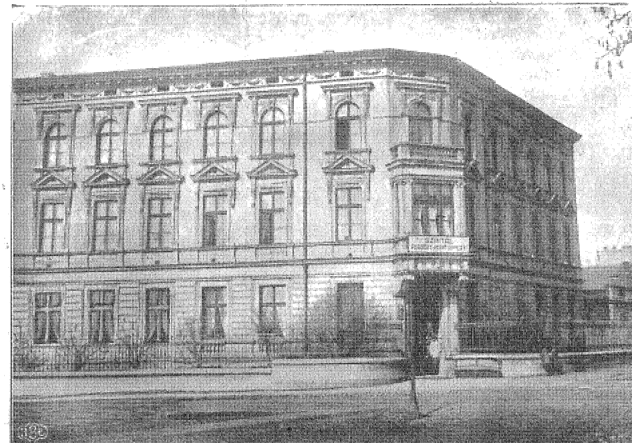
Widok gmachu, w którym się mieści klinika „Betleem“ od strony ul. Podleśnej.
