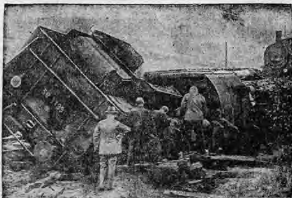
Turyngia nawiedzona została ostatnio przez niebywale burze, które spowodowały ogromne szkody. Na zdjęciu powyższym widzimy: pociąg wykołejony wskutek podmycia toru kolejowego przez deszcze.
