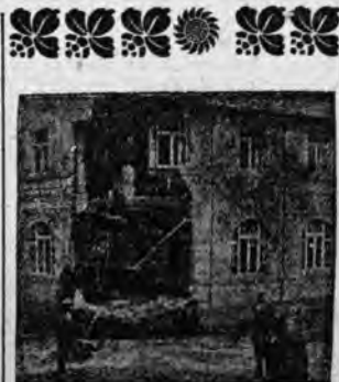
W miasteczku Stadtroda woda deszczowa tak dalece podmyła fundament domu, iż część jego zawaliła się.
