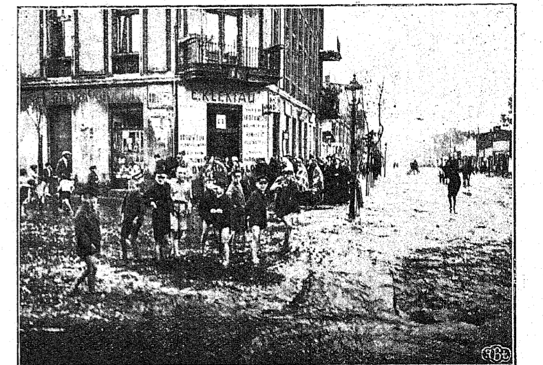
Fragment ulicy Rzgowskiej po ostatnich ulewnych deszczach.
