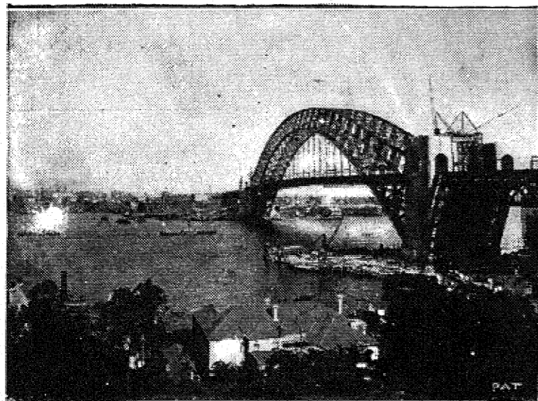
Ponad najpiękniejszą zatoką świata miasto Sydney (Australja) wybudowało olbrzymi jednoarkadowy most. Most ten oddany będzie oficjalnie dla ruchu dnia 19 marca 1932 r. Ma on 3,770 stóp długości i waży 50,200 ton. Na moście tym znajdują się 4 tory tramwajowe, 6 torów dla ruchu kołowego i 2 szerokie chodniki.
