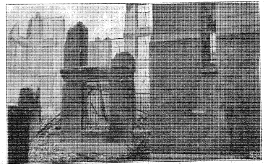
Szkielet zniszczonej przez pożar fabryki Wienera przy ul. Ceglarnianej 59. Budynek fabryczny, jak to widać ze zdjęcia, został zniszczony kompletnie.
