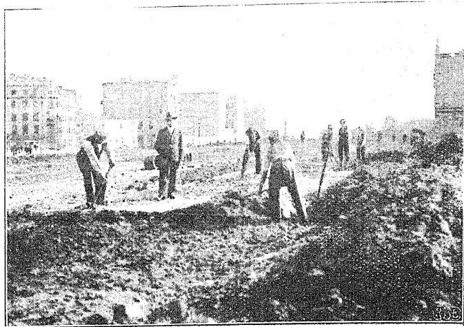
Budowa skweru przy dworcu Fabrycznym. Niwelacja terenu.
