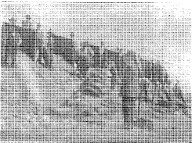
Budowa parku ludowego. Roboty ziemne niwelacyjne.
