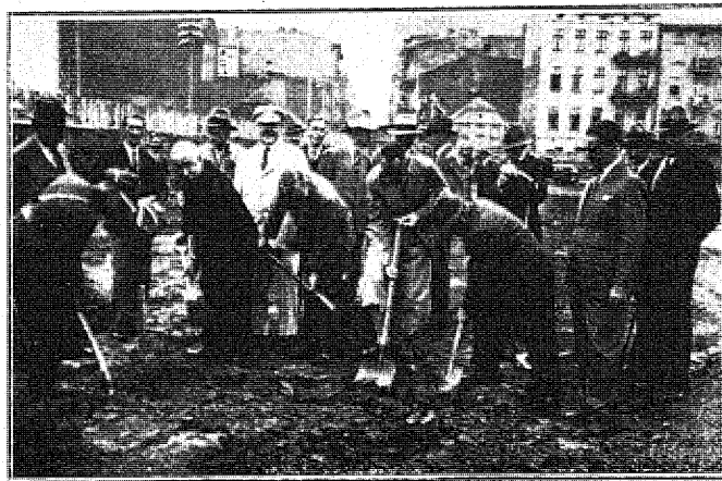
Przedstawiciele władz państwowych i miejskich, uczestnicząc przy rozpoczęciu prac budowlanych przy budowie Domu — Pomnika marsz. J. Piłsudskiego w Łodzi kopią łożysko pod fundamenty tego domu.
