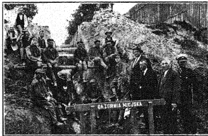
Roboty ziemne gazowni Miejskiej w Łodzi. Rewizja rur 14-calowych i przekładanie 8-calowych przy ul. Srebrzyńskiej.
