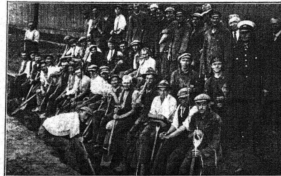
Roboty ziemne gazowni miejskiej w Łodzi. Rewizja rur gazowych 14-to calowych i przekładanie 8-mio calowych rur do zbiornika przy ul. Srebrzyńskiej.
