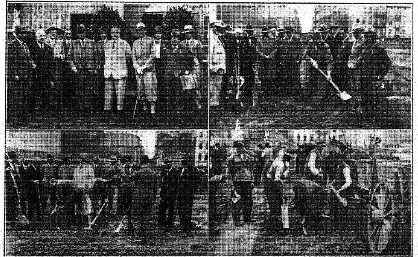
Przy zbiegu ulic Sienkiewicza i Strzeleckiej w Łodzi na olbrzymim placu, ofiarowanym przez Zarząd miasta naszego, rozpoczęły się już prace nad budową wielkiego Domu-Pomnika im. marsz. Józefa Piłsudskiego. Olbrzymie to dzieło realizowane drogą ofiarności społeczeństwa łódzkiego, ma stać się uwiecznieniem 20 letniej rocznicy odrodzenia Państwowości Polskiej i 40-lecia pracy Wodza narodu marsz. Józefa Piłsudskiego. Dom będzie symbolem mocarstwowej potęgi Rzeczypospolitej oraz kuźnią pracy obywatelskiej, jako siedziba wszystkich związków b. wojskowych, skupiających się w Federacji Polskich Związków Obrońców Ojczyzny. Pod pomnikowe to dzieło zakłada się już fundamenty. Na zdjęciu widzimy licznych przedstawicieli władz państwowych i miejskich, reprezentantów związków byłych wojskowych i społeczeństwa łódzkiego, uczestniczących w rozpoczęciu prac budowlanych.
