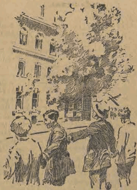
Młodzież wiedeńska broni przystępu do spalonego gmachu straży policyjnej przy ul. Lerchenfelsgasse.
