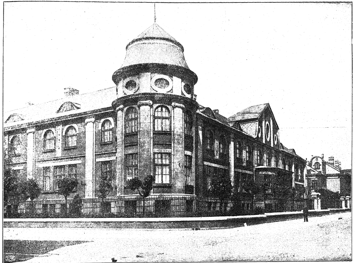
Siedziba zarządu wielkich Zakładów Zjednoczonych Włókienniczych K. Scheiblera i I. Grohmana Spółki Akcyjnej w Łodzi — Główne Biuro przy ul. Targowej 65.
