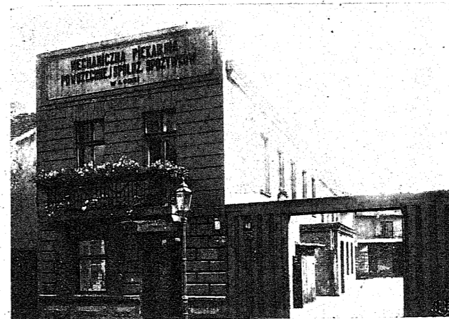
Budynek piekarni mechanicznej przy ul. 6-go Sierpnia 40 Powszechnej Spółdzielni Spożywców w Łodzi.
