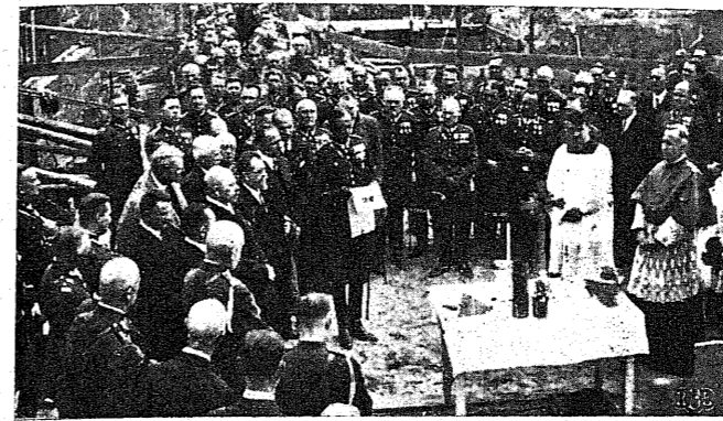
Uroczyste poświęcenie kamienia węgielnego pod budowę olbrzymiego szpitala wojskowego w Łodzi przy ul. Żeromskiego. Odczytywanie aktu erekcyjnego.
