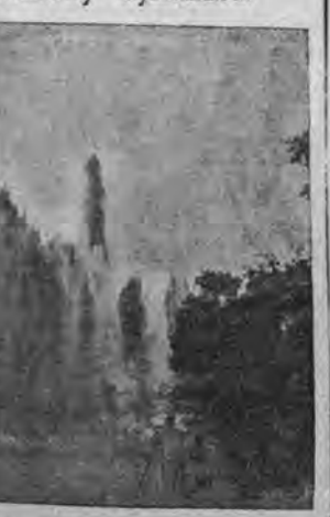
Przed kilku dniami użyto po raz pierwszy w Polsce dynamitu do prac meljoracyjnych, mianowicie: w celu wyrównania bardzo krętego biegu rzeki Orzuc pod Drodzowem na Polesiu, połączono dwa węzły rzeki linją nabojów dynamitowych, których wybuch utworzył linją, głęboką i równe koryto rzeki. Ilustracja nasza przedstawia groźny widok wybuchu pół-tonowego ładunku dynamitu.
