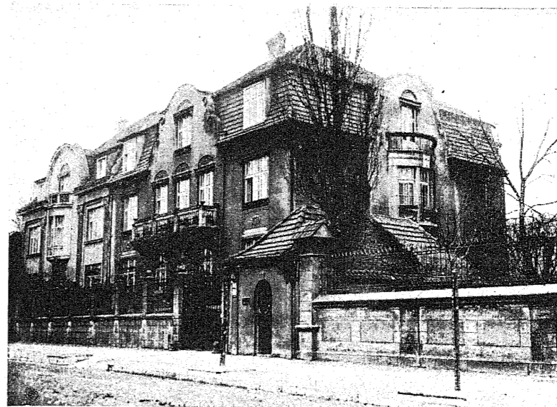
Społeczna Szkoła Powszechna p. n. „Szkoła Pracy” jest zakładem naukowym, prowadzonym według nowoczesnych metod wychowawczych. Szkoła ma już za sobą b. bogaty dorobek pedagogiczny. Na zdjęciu—budynek szkolny przy ul. Południowej 65.
