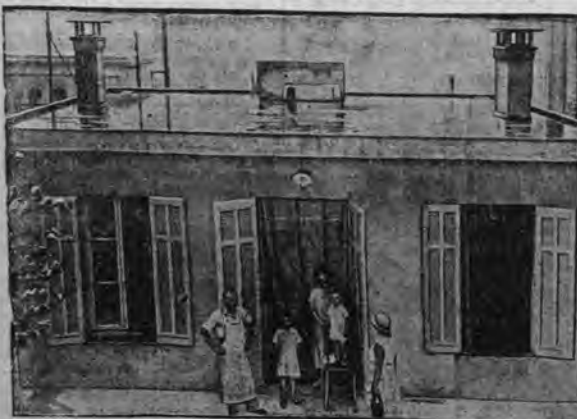
Jeden z mieszkańców Dallas (Stany Zjednoczone) wpadł na niezwykle oryginalny pomysł, ubezpieczający dom jego brzo od upałów. Urządził on — jak widzimy na powyższym zdjęciu — na dachu zbiornik wody, która przez rury napływa z pobliskich gór i splaya zwód na ziemię. Dzięki takiemu urządzeniu w wnętrzu domu panuje miła chłodna temperatura.
