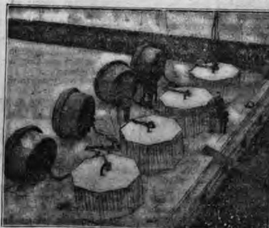
Na fotografii naszej widzimy szereg wielkich bloków, mających służyć jako znaki orientacyjne w porcie gdynskim. Bloki te będą zakotwiczone przy pomocy kilkunastu-tonowych bloków betonowych, które opuszczane na dno morskie
