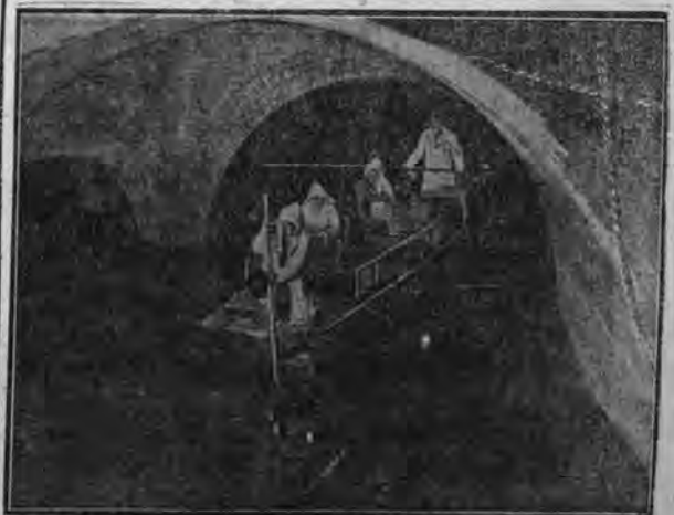
Jakby obrazek z średniowiecznej Wenecji... A tymczasem — jest to całkiem współczesna, prozaiczna przejażdżka inspekcyjna inżyniera oraz robotników kanalizacyjnych po kanałach podziemnych Hamburga. Sieć tych kanałów ma ogólną długość 800 kilometrów.
