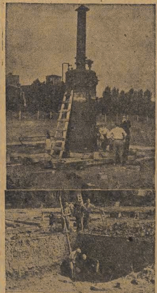
Prace ziemne przy budowie hali sportowej w Łodzi, szybko posuwają się naprzód.
