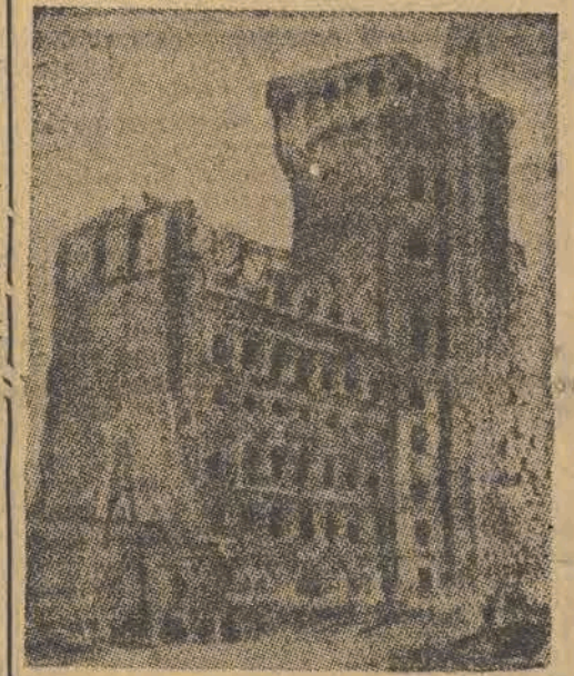
58-metrowej wysokości gmach Centrali Telefonów znajduje się w stadium odbudowy.
