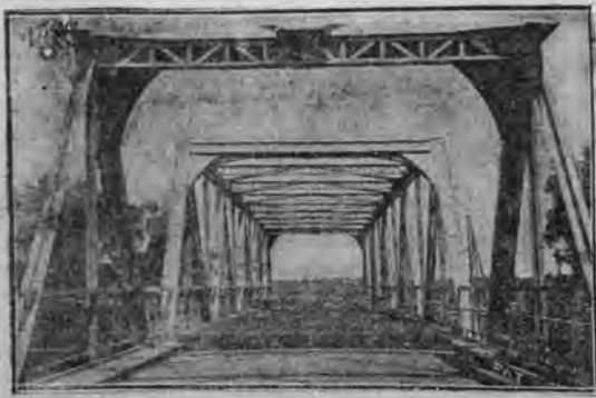
Na rzece Muchawcu pod Brześciem n/B stanął żelazny most drogowy długości 75 m. — Podajemy fotografię nowego mostu
