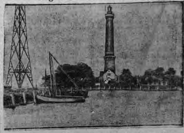
Latarnia morska w Swinoujściu, wobec podmycia jej podstawy przez wodę, grozi runięciem.
