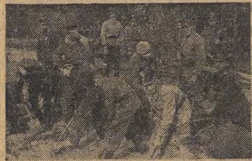
Jak już pisaliśmy, ludność okolic ul. Dąbrowskiej, gdzie prowadzone są roboty nad przedłużeniem linii tramwajowej dla tej dzielnicy, ohochnie zgłosiła się i pomaga przy dokonywanych pracach.
