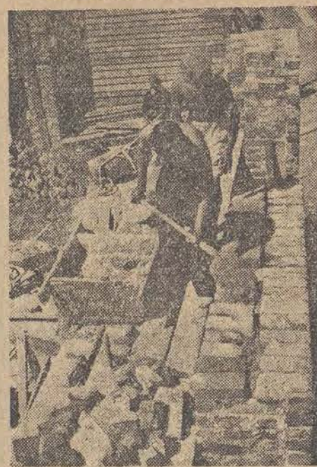
Na osiedlu Mirów w Warszawie przy budowie bloku mieszkalnego pracuje samodzielnie brygada młodzieżowa ZMP. Na zdjęciu — Lucjan Świątkowski i Tadeusz Szczęśniak.
