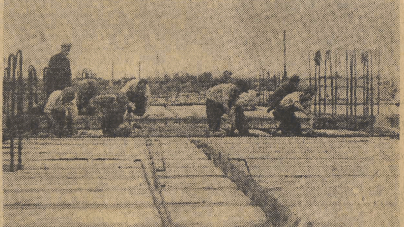
Budowa stropów nowym systemem w chłodni Kazimierzów pod Szczecinem
