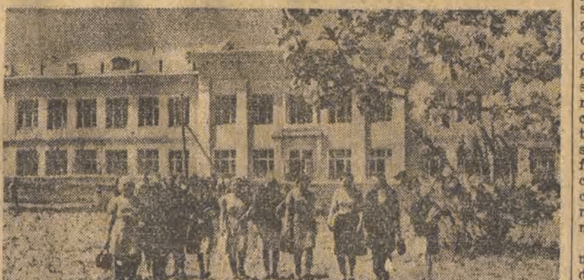
Piękny jest budynek szkoły wiejskiej w Dymitrowce
