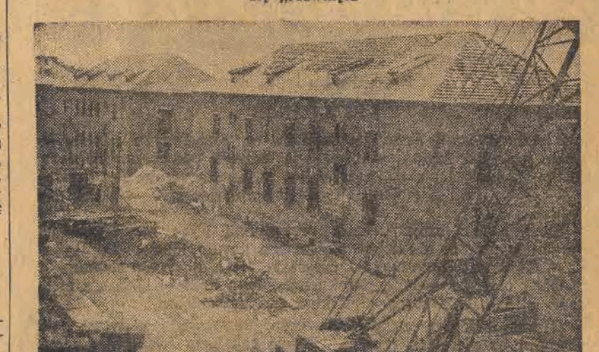
5) 3 grudnia — pierwsze budynki pokrywa się już dachówką. Nowe osiedle na Stokach jest na ukończeniu. „Taśma zdała egzamin”
