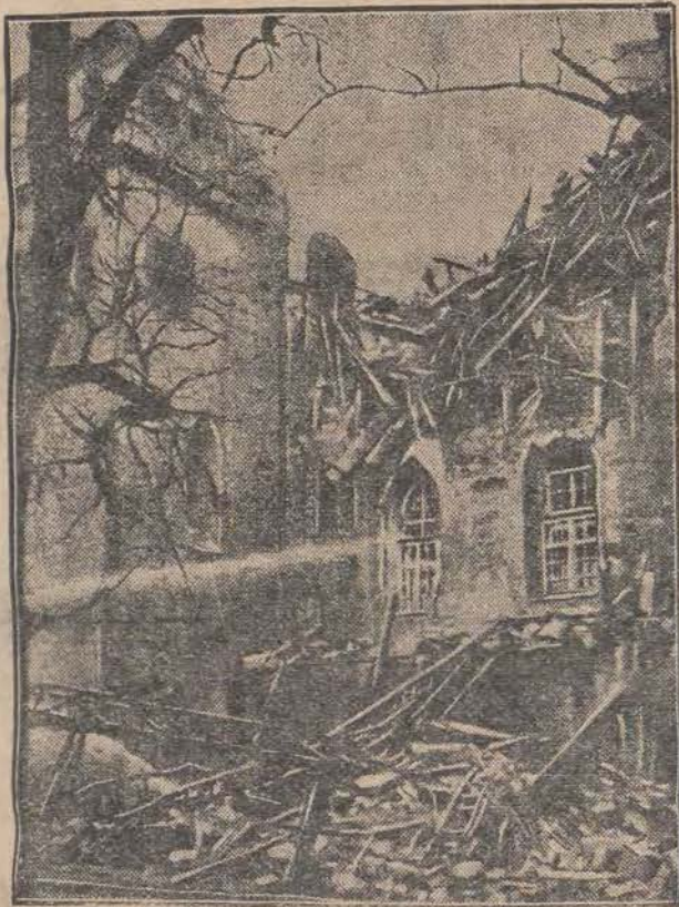
Die Brandruinen des Alten Schlosses in Stuttgart Eine Aufnahme vom eingestürzten Teil der Südfront des Alten Schlosses mit der Schloßkapelle.
