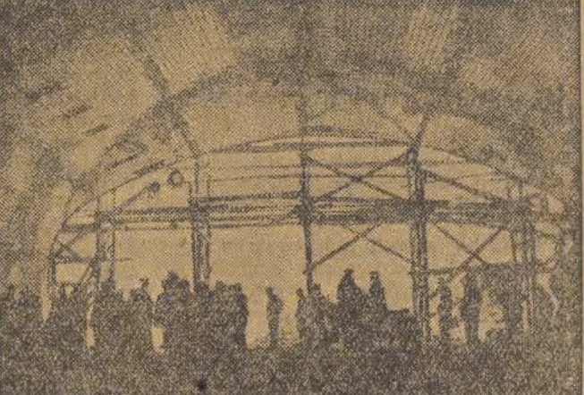
Na zdjęciu — tunel wyłożony isnącą glazurą.
