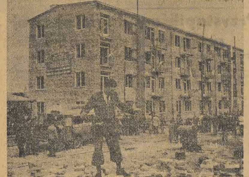
2 września zakończono budowę szybkościowego domu w Warszawie. Budynek wykonano w ciągu... 12 dni.
