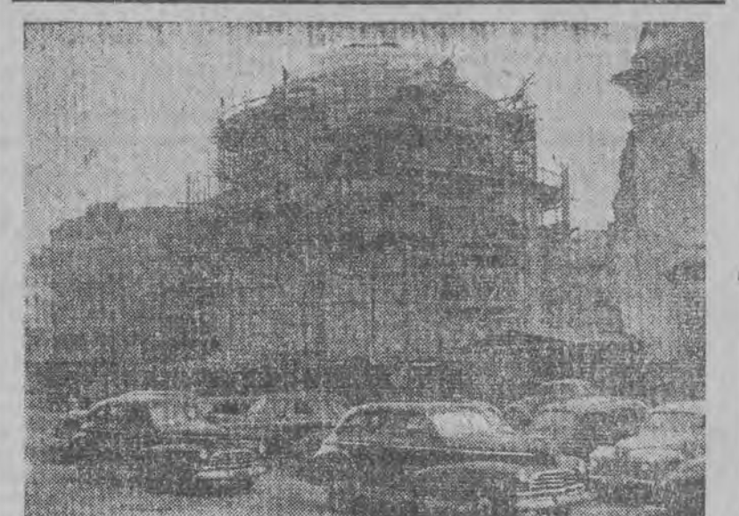
Odbudowa kościoła św. Aleksandra na pl. Trzech Krzyży w Warszawie
