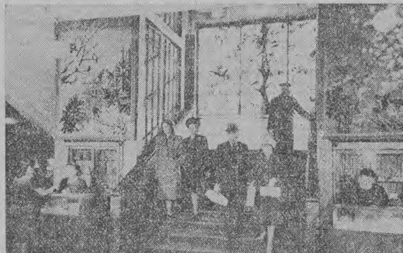
Widok wewnętrzny Pałacu Zakupów.
