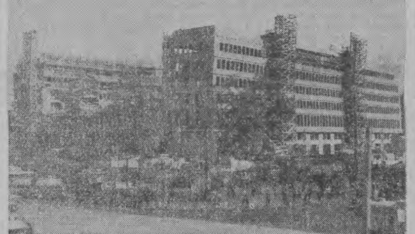
Budowa Centralnego Domu PZPR
