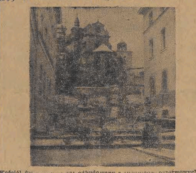
Kościół św. Józefa, ostatni obiekt odbudowany z ruin osiedla państwowych. Na pierwszym planie prace przy budowie trasy W-Z
