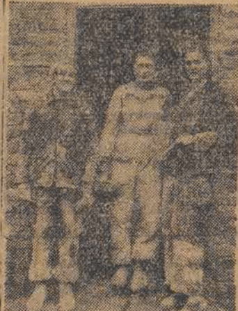
Trzyosobowy zespół kobiety pracujący przy budowie osiedla ZOI na Młynowie w War szawie wyłknął w ciągu 7 godzin 75 m kw. muru (799 procent normy jednego murar za)! Na zdjęciu - zespół re kordzistek: od lewej Antonina Traczyk (murarz) oraz pod reżne: Kazimiera Wysocka i Irena Kozłoj
