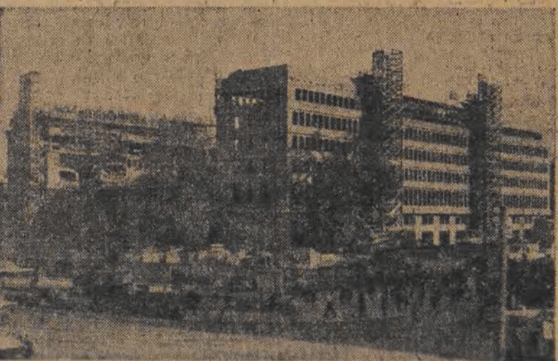
Budowa Centralnego Domu PZPR
