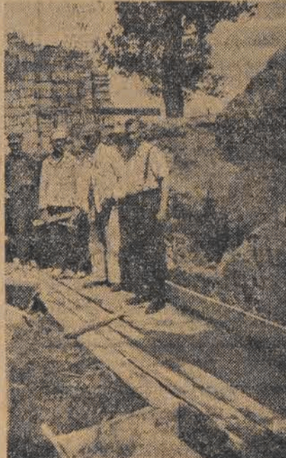
Budowa mieszkań robotniczych w Woli Krzysztoporskiej
