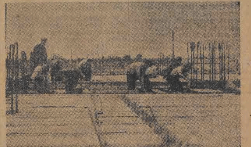
Budowa stropów nowym systemem w chłodni Kazimierzów pod Szczecinem
