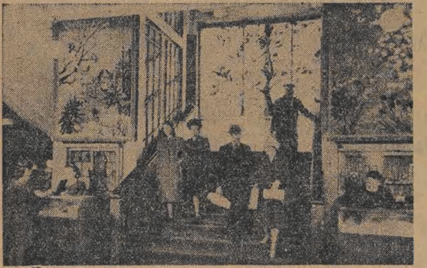
Widok wewnętrzny Pałacu Zakupów.
