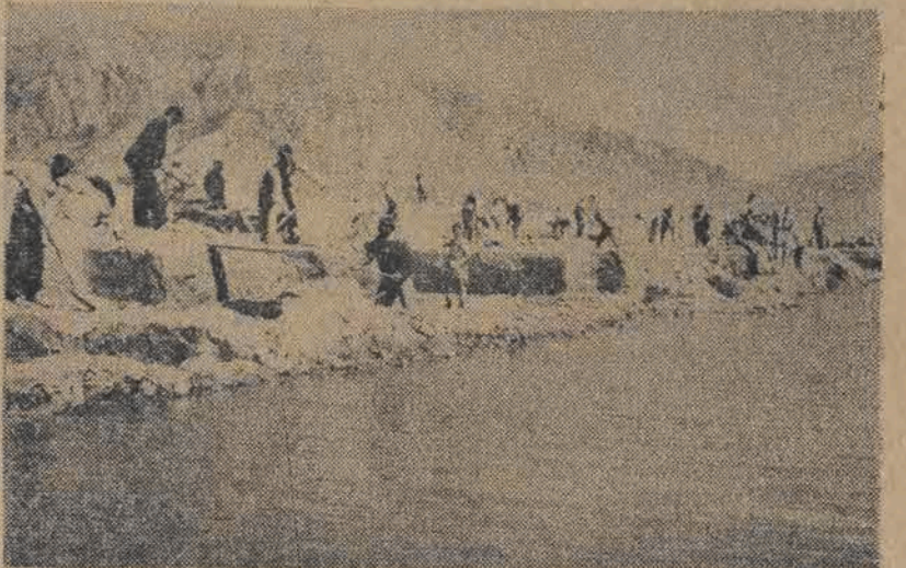
Budowa kanału Maliq w Albanii.
