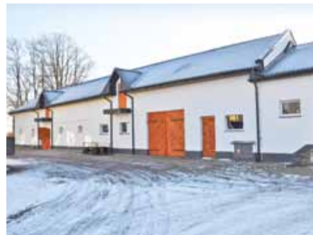
W przebudowanym budynku magazynowym powstała stajnia z 5 boksami dla koni.
