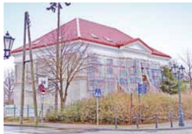
Postęp prac przy elewacji byłego Domu Partii najlepiej widać od strony ul. 3 Maja.
