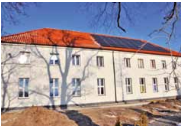
Na wyremontowanym budynku internatu zamontowane zostały panele fotowoltaiczne o mocy 34 kW.
