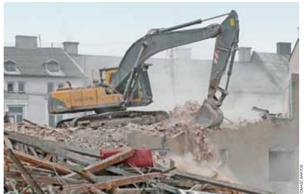
Koparka na hałdzie gruzu dokonująca wyburzenia ścian kamienicy przy ul. Podrzecznej 12.
