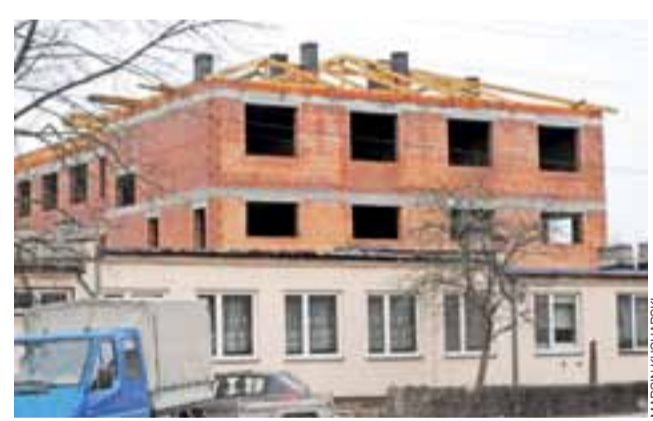
Widać już konstrukcję dachu na nowym budynku MOS w Kiernozi.
