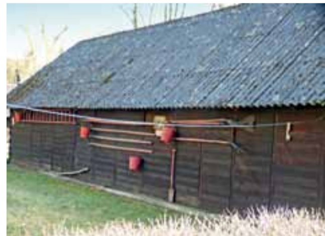
Eternit na dachach obiektów w skansenie został położony pod koniec lat siedemdziesiątych XX wieku, zgodnie z panującą wówczas modą. Nadszedł czas, by wreszcie go zmienić.
