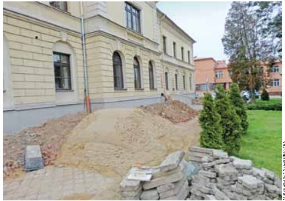
Budowa kanalizacji deszczowej przy zabytkowym budynku ma zapobiec dostawianiu się wody do jego piwnic.
