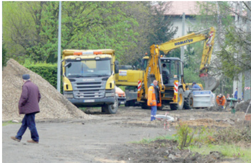
Prace przy budowie ul. Niciarnianej idą pełną parą, na tej ulicy nowe latarnie już stoją, budowana jest kanalizacja deszczowa i rozpoczęto budowę nawierzchni.
